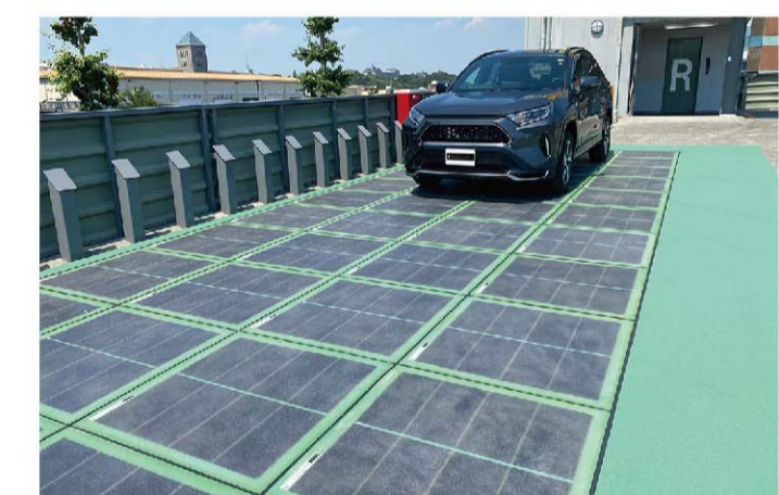
▲ 太陽光路面発電の実証実験の様子
