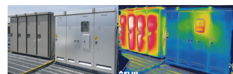
▲ 施工済み分電盤は表面温度が低い
